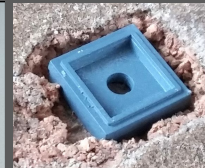
Fundamentfuß vor dem Einbau
